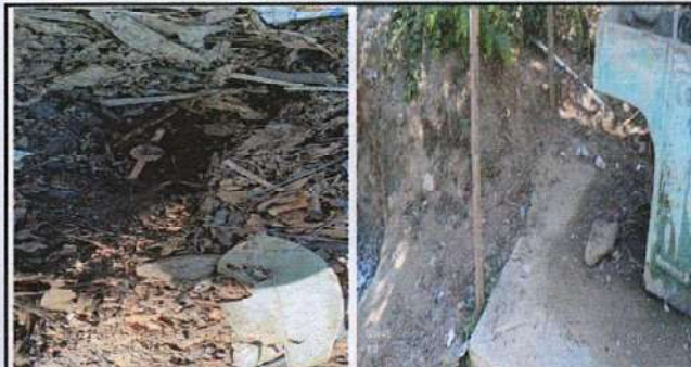
Foto 4: Cambio de llave de agua potable dañana
