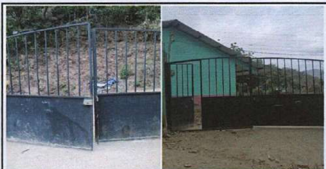
Foto 5: Reparacion de porton Lijado y pintura
